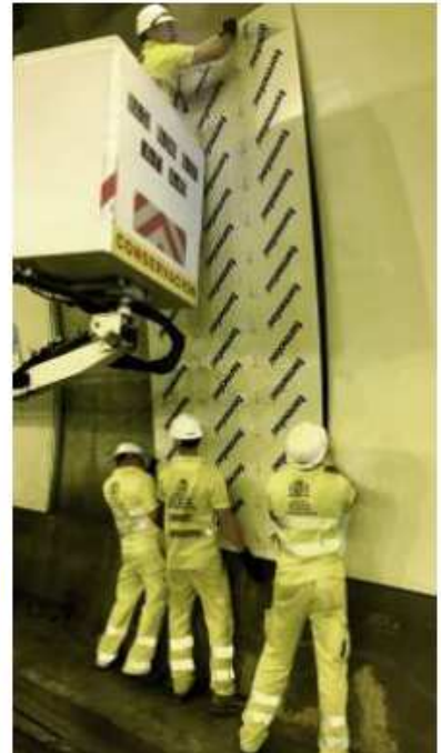
Forrado de tuneles
